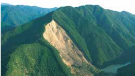
紀伊半島大水害で発生した深層崩壊（長殿谷）▼
